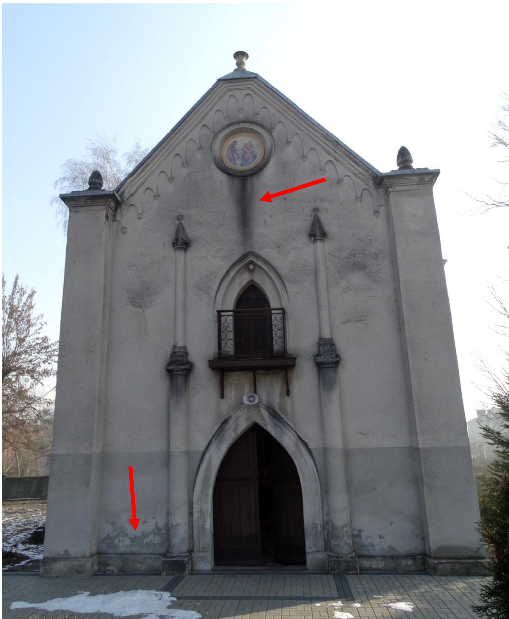
Fot. nr.1 Budynek Kaplicy Świętej Trójcy w Proszowicach- widoczne liczne zacieki odspojenia tynków, zawilgocenia, Stan przed wykonaniem badań konserwatorskich.
