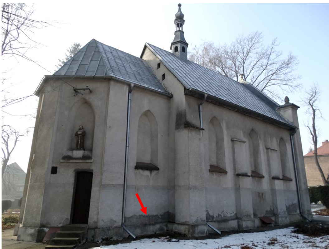
Fot. nr.2 Budynek Kaplicy Świętej Trójcy w Proszowicach- widoczne liczne zacieki odspojenia tynków, zawilgocenia, doraźne naprawy. Stan przed wykonaniem badań konserwatorskich.
