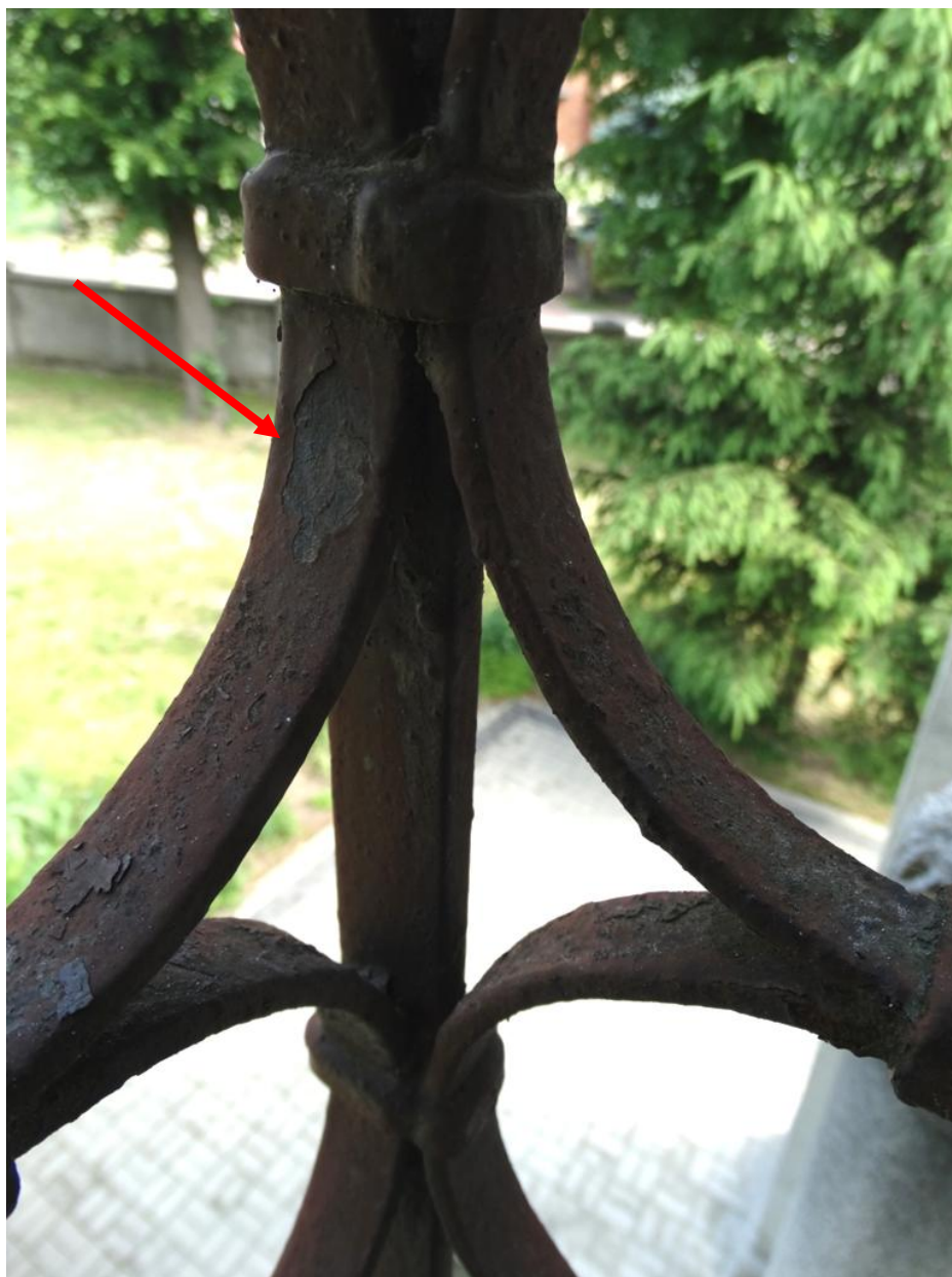
Balustrada metalowa balkoniku-widoczna wcześniejsza czarna warstwa farby oraz późniejsza w kolorze brązu, korozja struktury.
