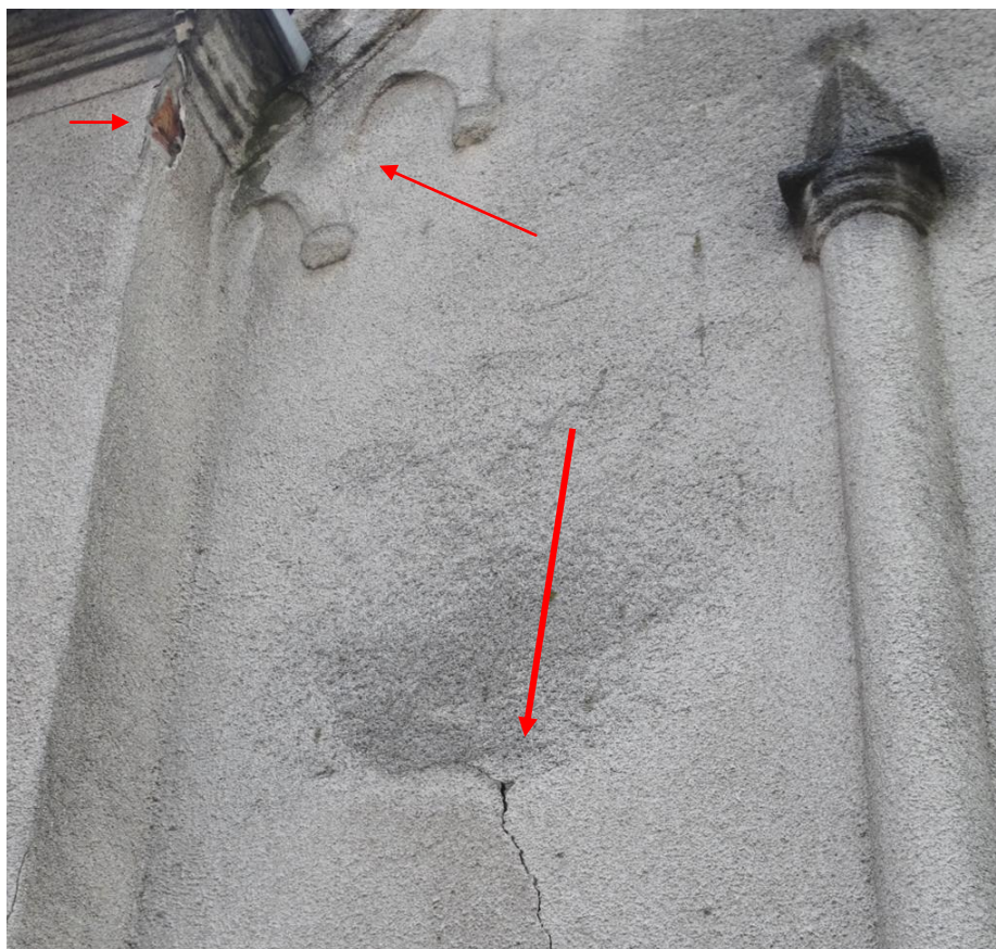
Fot. nr.4. Zawilgocenia w dolnej części budynku, brak odprowadzenia wody, woda zamarza i rozsadza strukturę, pęknięcia , odspojenia tynku cementowego , brak czytelnej formy arkad poprzez zbyt gruby narzut tynku.
