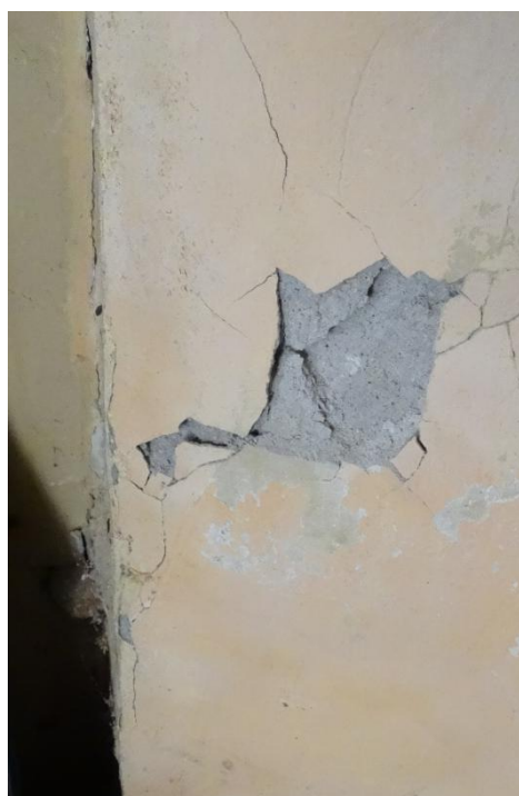
Fot. nr. 5. Widok wnętrza budynku kaplicy - zawilgocenia, wysolenia na ścianach w ich dolnej części
