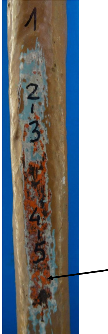
Krata zabezpieczająca jednego z okien, z widoczną odkrywką do najstarszej warstwy w kolorze minii.
