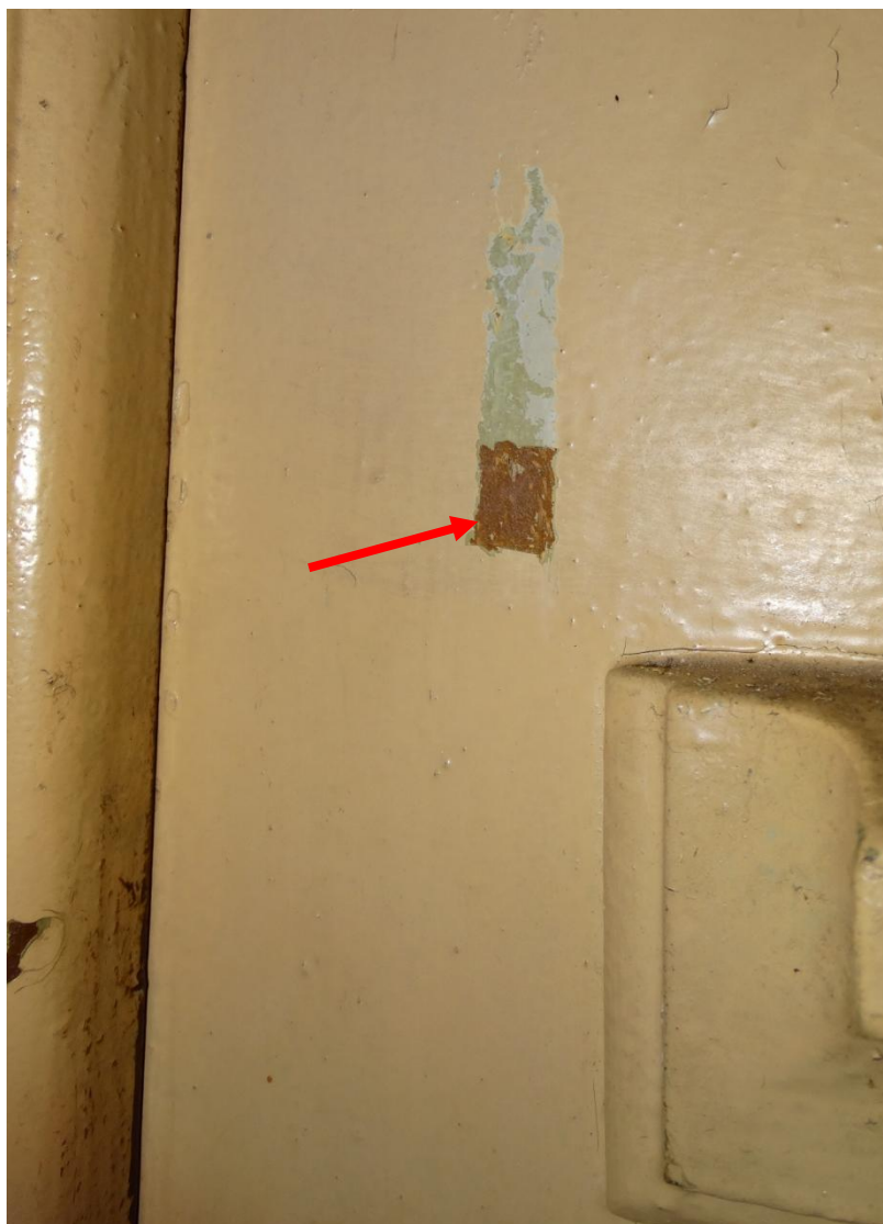
Drzwi drewniane wejściowe-widok od wnętrza budynku – odkrywka ukazująca pierwotną brązową warstwę malarską.
